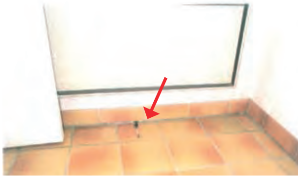
Affaissement du plancher mis en évidence par le décallement entre plinthes et dallage - Maison Jourdan.
