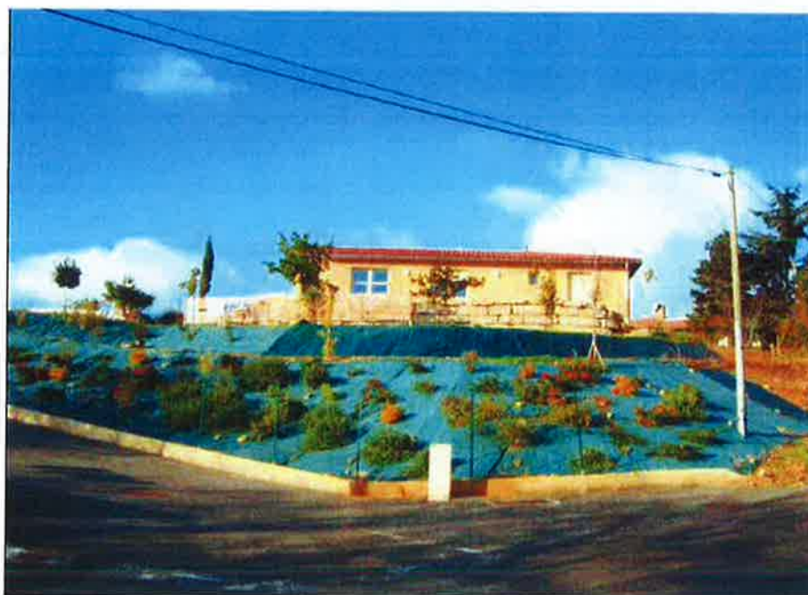
photo n° 5 – remblais et enrochement à la parcelle n° 641
